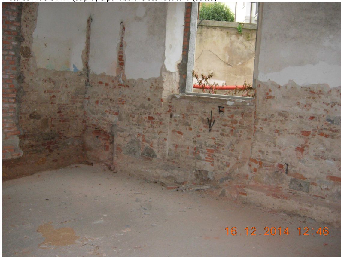
Vista corridoio P.P. (sopra) e particolare stonacatura (sotto)
